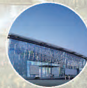
产业园区工程
