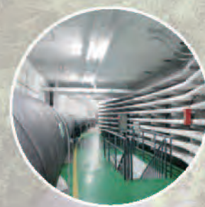
城市综合管廊工程
