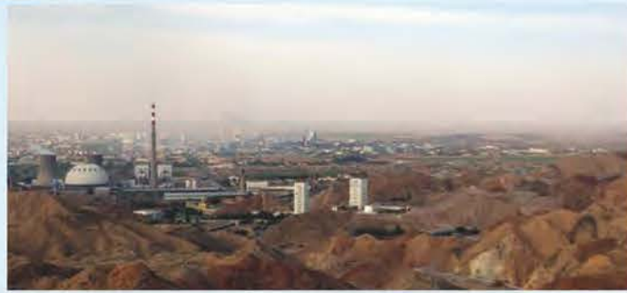
金川工程 Jinchuan Project
