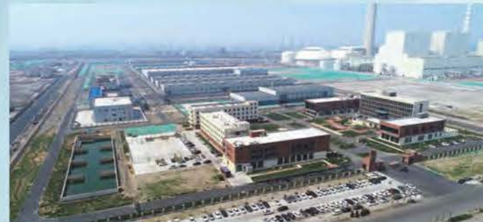
中冶新材料项目 MCC Ramu's Ternary Precursor Project
